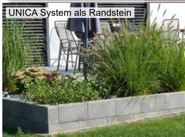
UNICA System als Randstein: links überstehend, rechts bodengleich als Übergang zum Haus bzw. Eingang
